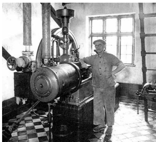
De gamle andelsmejerier på Brørup egnen var små og gammeldags. Derfor ønskede man at bygge et nyt og moderne. Her ses dampmaskinen på det gamle Brørup Andelsmejeri.
